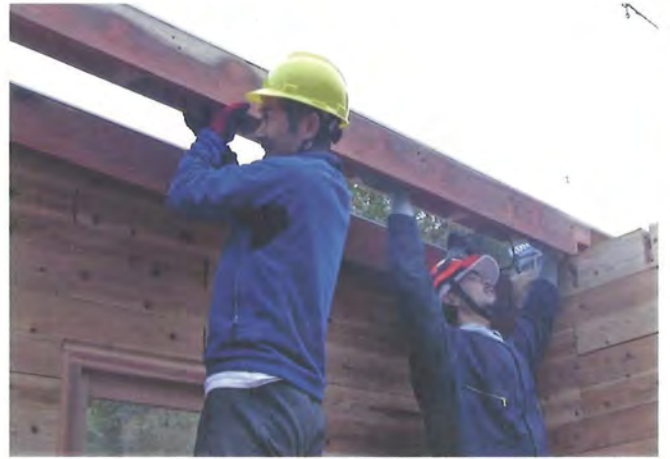
窓枠と窓を設置し、さらに積み上げていく。窓を割らないように様子を見ながら、木槌で慎重にたたく。屋根パーツを乗せ、入り口にドアを設置して完成。
