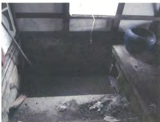
「川戸」はどうするか検討中。 田植えの時期、田んぼの水が流れ込んで来る。 この泥はどれほどの厚みなのか？ ほりだしてストーブゾーンにして暖まるうか！ 窓がヌケているのでここに煙突を出そう。
