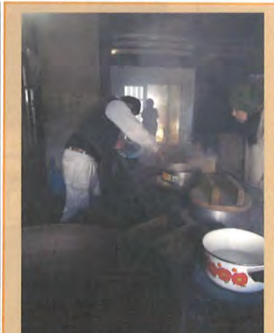
五連の竈に火を入れた。恐る恐る煙突から一番遠い所からスタート。煙が通らず家中煙だらけになる。最初は煙突に近い所から始めるのが鉄則であった！
