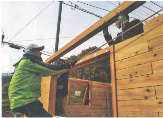
窓枠と窓を設置し、さらに積み上げていく。窓を割らないように様子を見ながら、木槌で慎重にたたく。屋根パーツを乗せ、入り口にドアを設置して完成。
