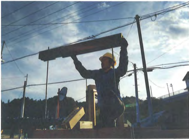
試作第1号では、十分な耐震強度を得るため、補助的に鉄筋を使用している。
