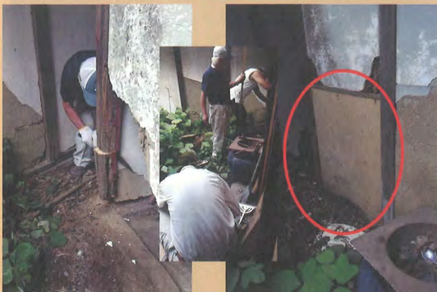
北の角の柱の下が虫食いで浮いていた。おまけに壁が崩れ大きな穴が！ 柱を切り、丸太をかまし、壁を落としコンパネで裏表2枚で塞いだ。 電動ノコで助けてくれた小杉さんに感謝！ コンパネに弁柄を塗って完成。
