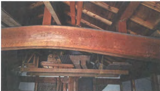
天井は木材。障子、トタン角材、板など建具がストックされている。
