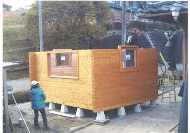
試作第1号では、十分な耐震強度を得るため、補助的に鉄筋を使用している。
