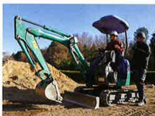
作業道作設実習
