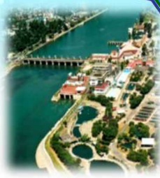
瀬田川洗堰およびバイパス水路
