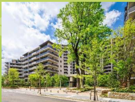
第39回 国土交通大臣賞 江古田の杜グリーンラボ協議会/ 積水ハウス(株)/(独)都市再生機構/(医)健真会総合東京病院
