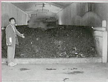
▲生ゴミの堆肥化施設 (22.2トン処理/日)
