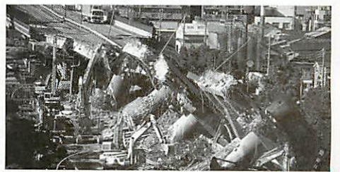
阪神・淡路大震災により分断された道路
