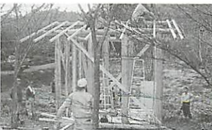
●間伐材を利用した、森林保全の拠点を住民の手で建設中。
